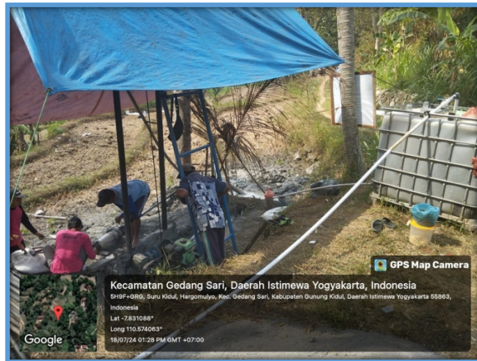
Gambar 6. Kegiatan pengeboran sumur (Sumber : Dokumentasi Penulis, 2024)
